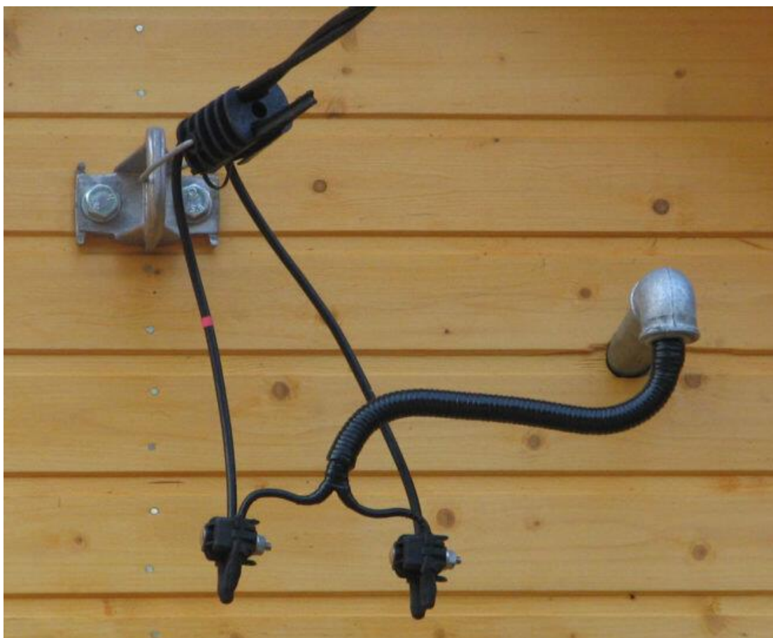
Рисунок 2: Ввод СИП в частный дом
