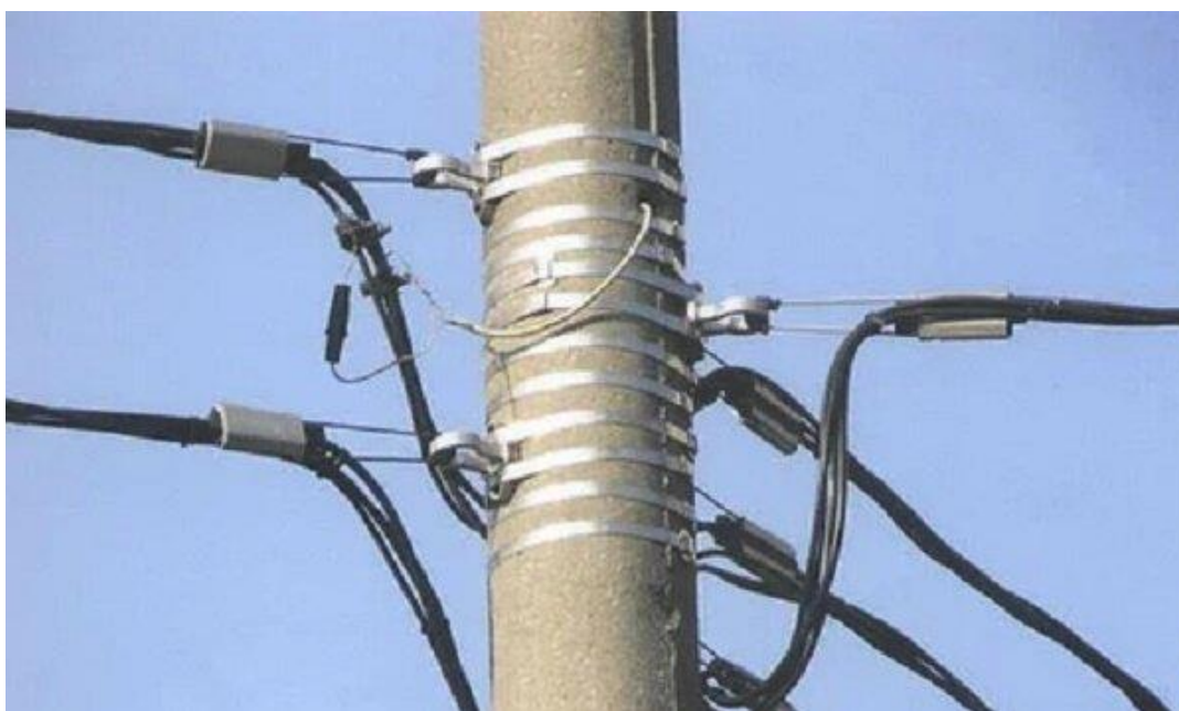
Рисунок 3: Правильное крепление СИП на столбе
